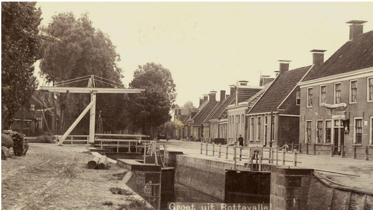
Rottevalle, Muldersplein en Herberg Het Wapen van Smallingerland rond 1902 met nieuwe wipbrug bij Brouwershoek en de vernieuwde ijzeren sluis.
