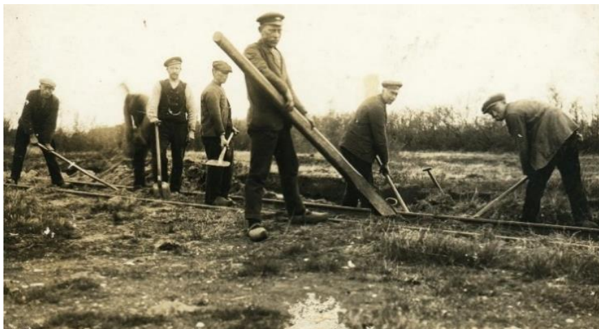
Aanleg spoor stoomtrein Drachten-Sumar 1896
